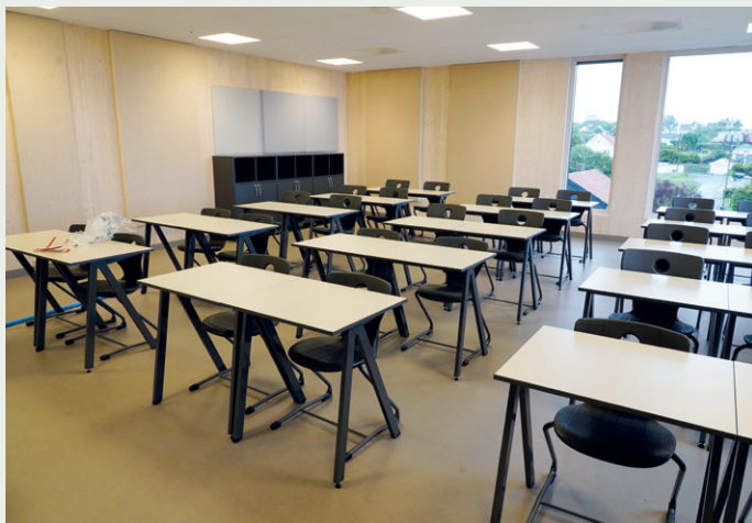
Undervisningsrom med vegger av krysslaminerte treelementer og lydabsorberende finerplater.
