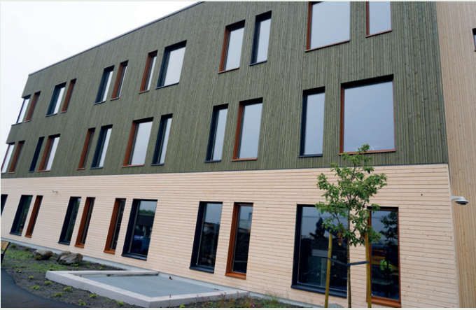
Det meste av skolens fasade er kledd med høytrykksimpregnerte og profilerte bord av gran.
