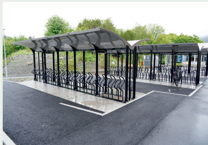
Sykkelparkeringsanlegget er utstyrt med tak og belysning.
